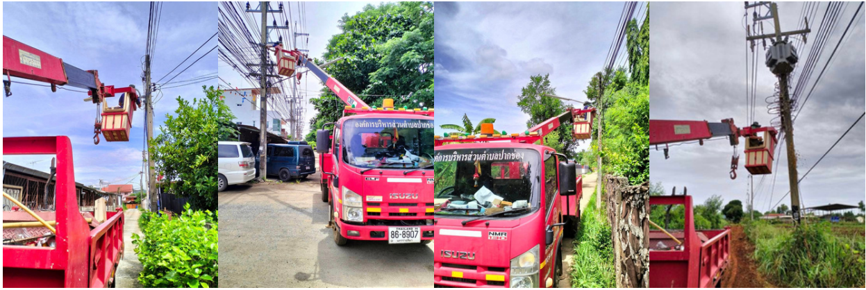
เดือนกรกฎาคม 2567 กองช่าง อบต.ปากช่อง ดำเนินการออกซ่อมแซมไฟฟ้าแสงสว่างในเขตพื้นที่ตำบลปากช่อง จำนวน 7 หมู่บ้าน
