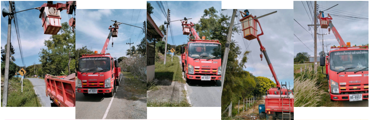
เดือนพฤศจิกายน 2567 กองช่าง อบต.ปากช่อง ดำเนินการซ่อมแซมไฟฟ้าแสงสว่าง ภายในตำบลปากช่อง จำนวนทั้งหมด 13 หมู่บ้าน
